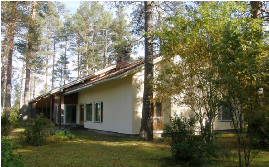
Insinöörin talo Nuojuan Nokkalassa. Kuva Juhani Turpeinen, PPM 2009.
