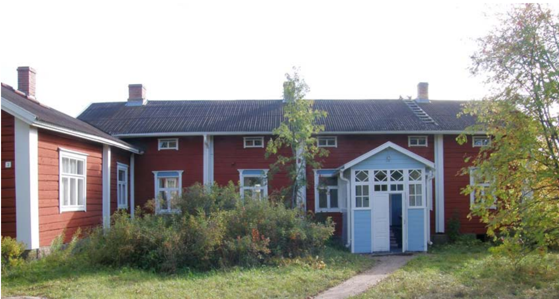
Laaksolan päärakennus Haapavedellä. Kuva Juhani Turpeinen, PPM 2009.
